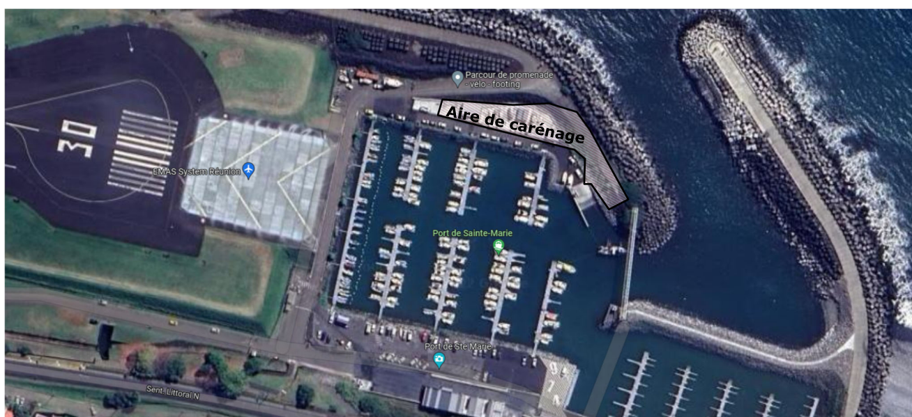
Figure 5 : Aire de carénage
